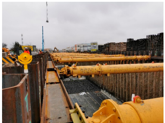
Abb. 6: Totalstation auf Konsole für GTM (links) und Messpunkt der Baugrubensicherung auf der Spundwand (rechts)
