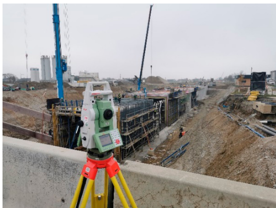
Abb. 4: Errichtung des Tunnelbauwerkes FW2 in offener Bauweise mit Anschlussstandpunkt an das oberirdige Netz (links) und zugehörige Netzmessung untertage (rechts)
