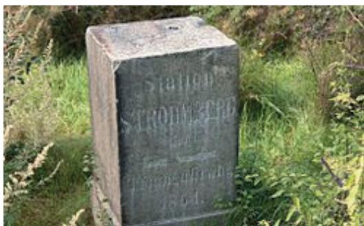
Abb. 39: Vermessungspunkt der Mitteleuropäischen Gradmessung 1864
