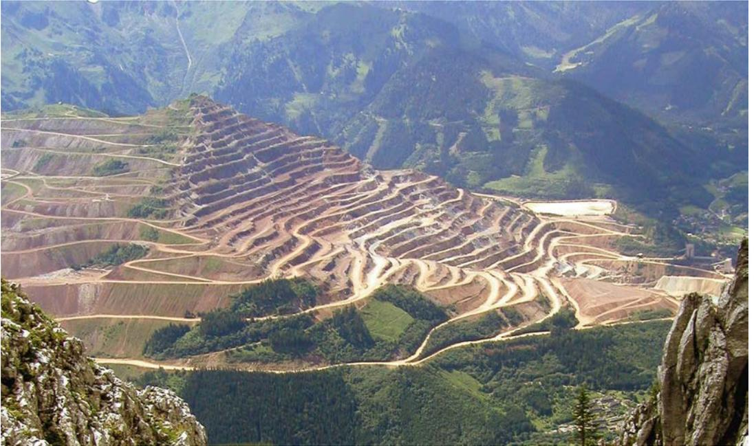
Abb. 1: Terrassenförmiger Tagebau am steirischen Erzberg
