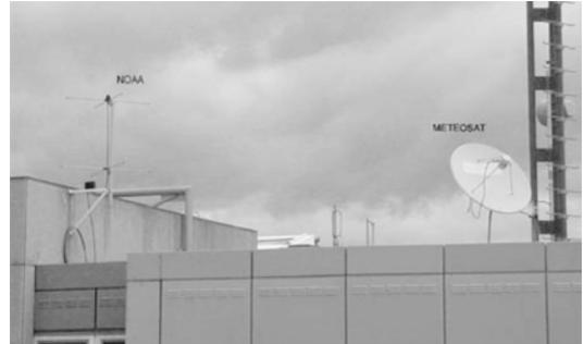
**Abb. 12:** Demonstrationseinrichtung zur Satelliten-Fernerkundung: links omnidirektionale Dipol-Antenne für NOAA (polständige Umlaufbahn), rechts Parabolantenne für METEOSAT (geostationär)
