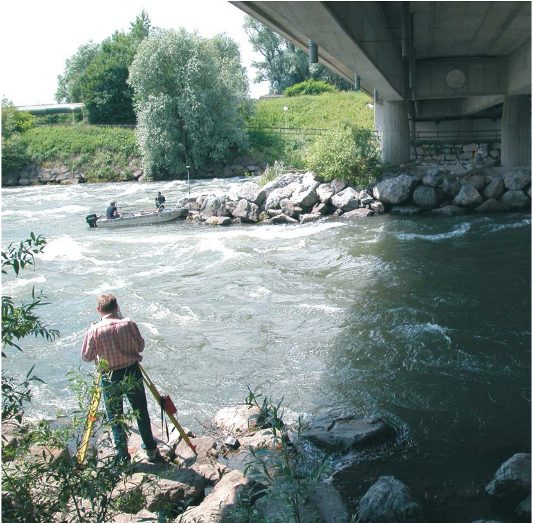
Abb. 1: Blockwurf im Schwallstreckenbereich der Mur in Graz
