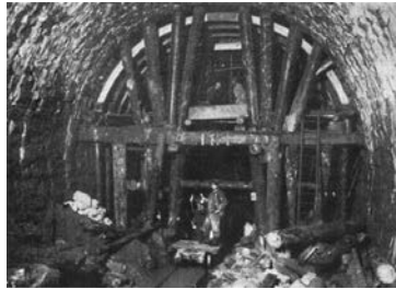
Abb. 52: Gewölbeausmauerung
