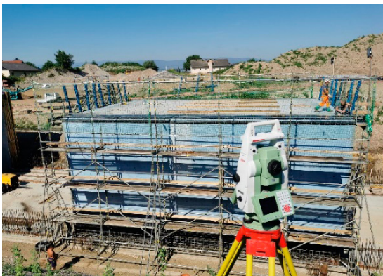
Abb. 7: Kontrolle der korrekten Positionierung des Schalwagens im unverbauten Abschnitt (links) und Schalwagenquerschnitt zwischen Spundwänden im verbauten Gebiet unter der B67 (rechts)
