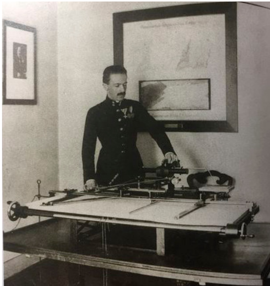
Abb. 8: Olt. Eduard v. Orel mit Rost-Autostereograph M1908
