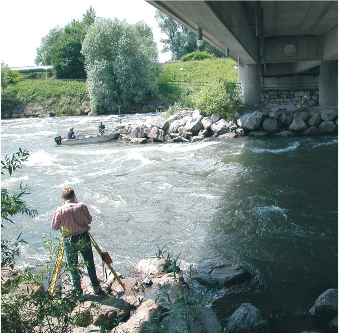
Abb. 1: Blockwurf im Schwallstreckenbereich der Mur in Graz
