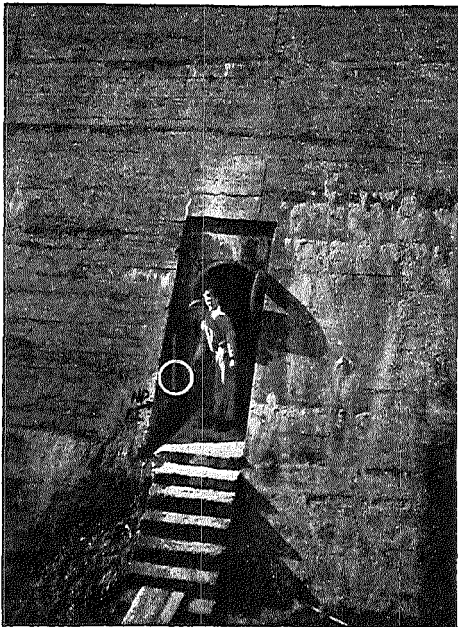
Abb. 31: Stollennivellement Luftseitiger Bolzen
